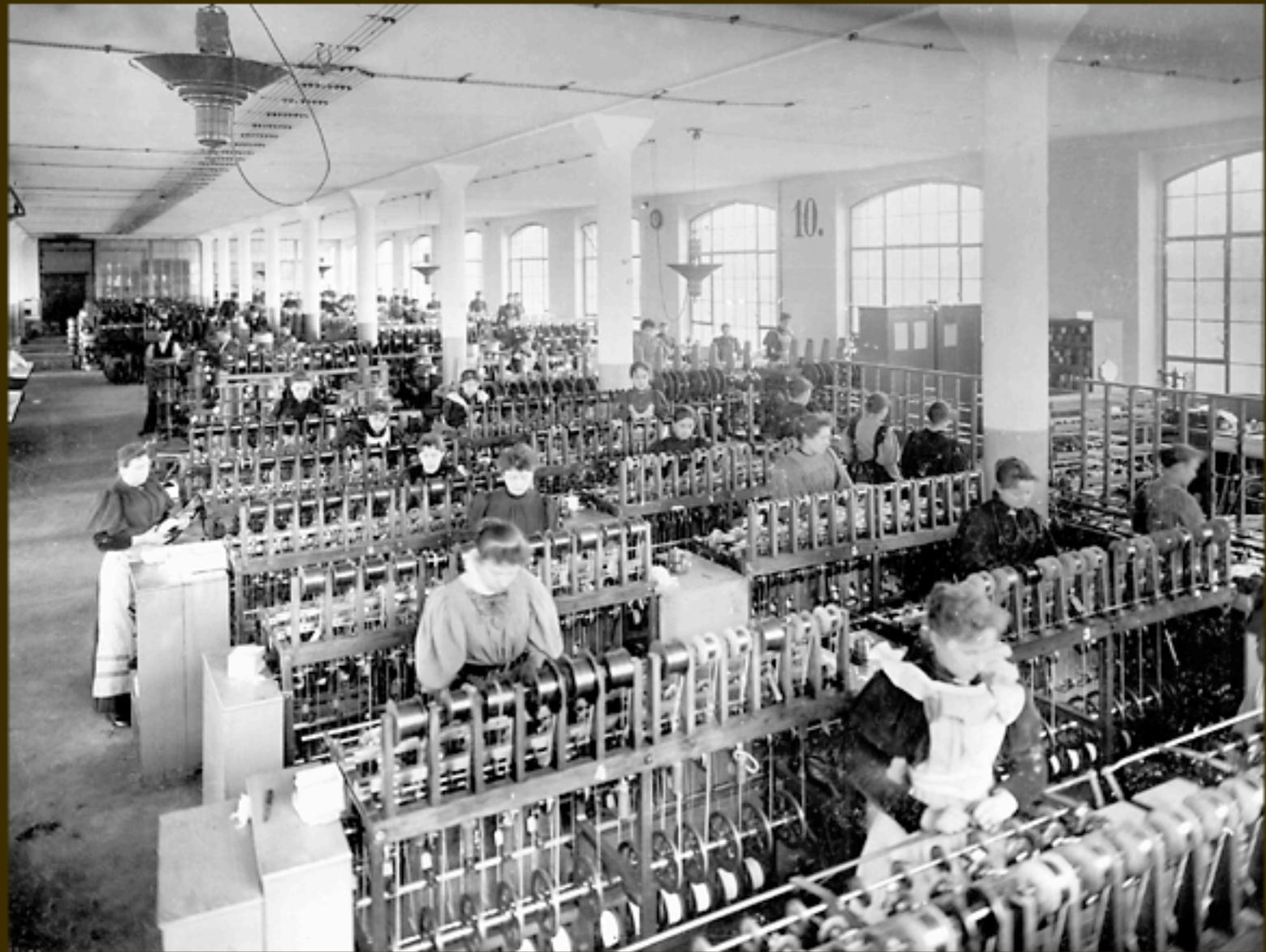
In einer Kabelfabrik wird Draht umgesponnen
